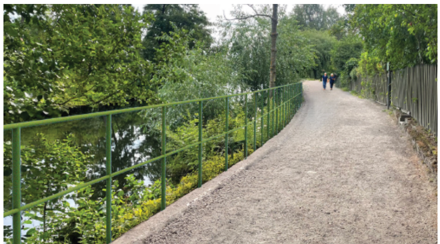
Fotomontage som visar påldäcket längs kolonilottsområdet med slitlager av stenmjöl och räcke av stål.
